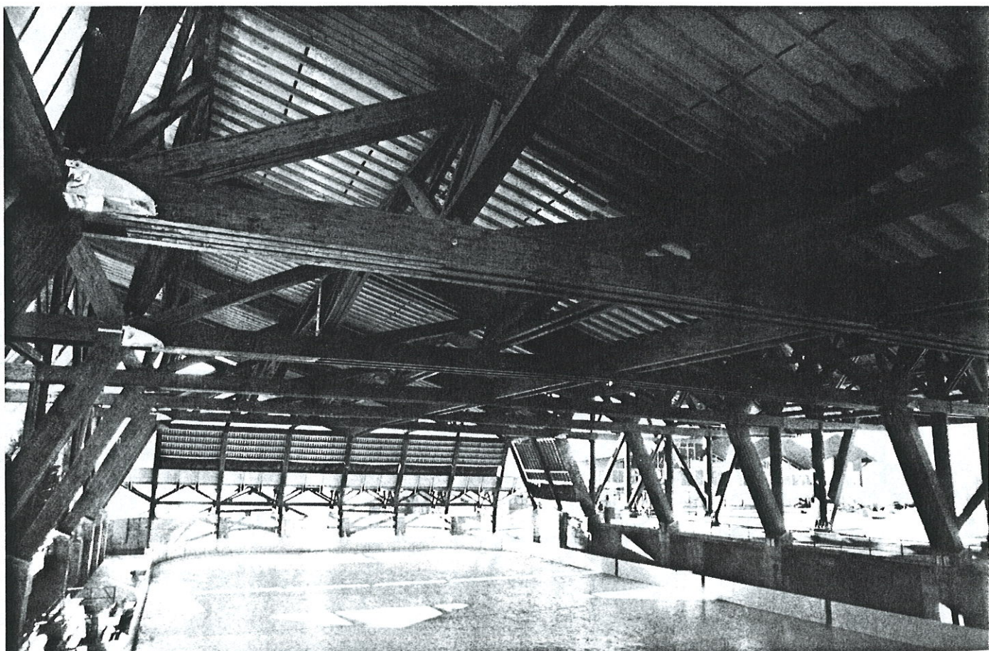
Für die grösste bisher in der Schweiz errichtete Holzkonstruktion der Schwimmhalle (oben) und der Eissporthalle (unten) in Verbier VS sind gegen 1000 m 2 Holz verbaut worden.
