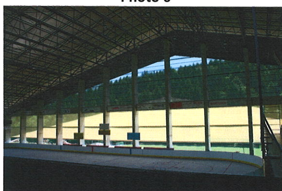
GALEBREAKER Patinoire Leysin vue de l'intérieure
