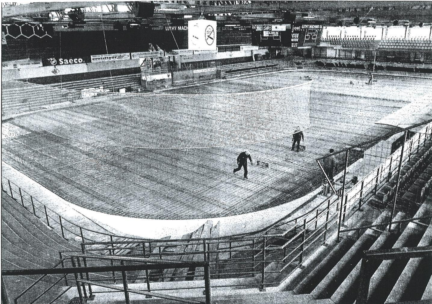
Le nouveau réseau de refroidissement de la patinoire compte 22 kilomètres de fins tuyaux. La soudure dans les coudes doit être d'une extrême précision pour éviter tout risque de fuite.
