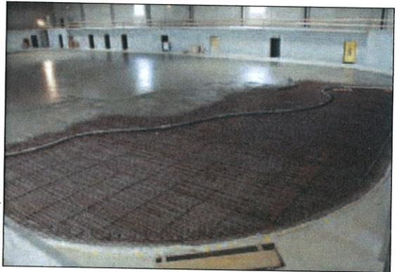
■ Les structures métalliques et les tuyaux de refroidissement sont noyés dans la masse de béton qui forme la dalle.
