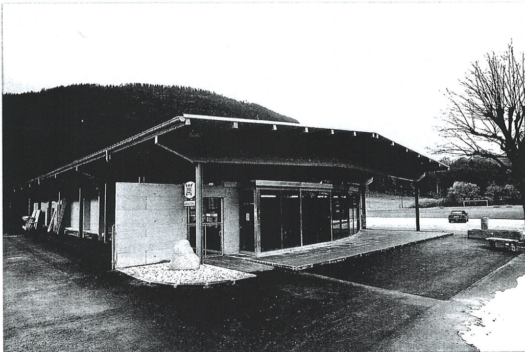
Bâtiment de service
