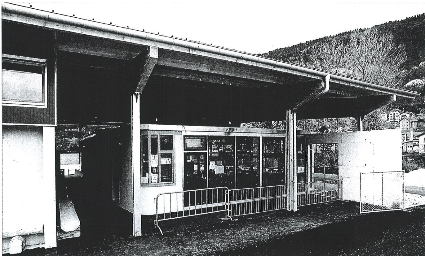
Les fermes en lamellé-collé reposent sur des piliers métalliques
