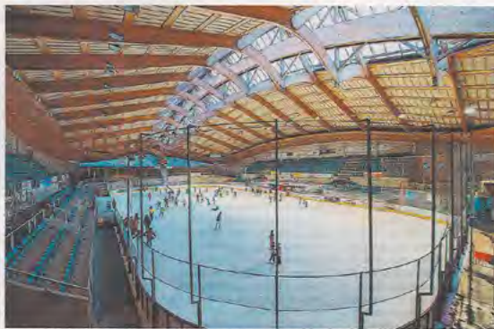
La patinoire est le bâtiment communal le plus énergivore, à raison de 200 000 fr. par an. JEREMY BOVY
