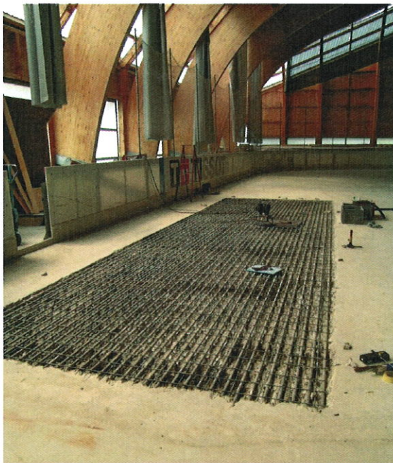
Photo 2 – Zone hydrodémolie de la piste de froid
