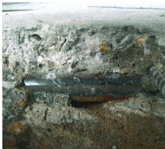
Photo 3 – Traces de corrosion sur la face inférieure du tuyau
